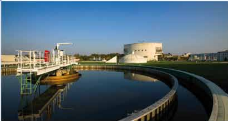
Impianto di trattamento acque – Berlino
