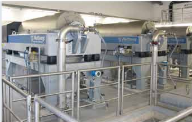
DECANTER Z5E in un impianto tedesco per il trattamento di acque reflue
