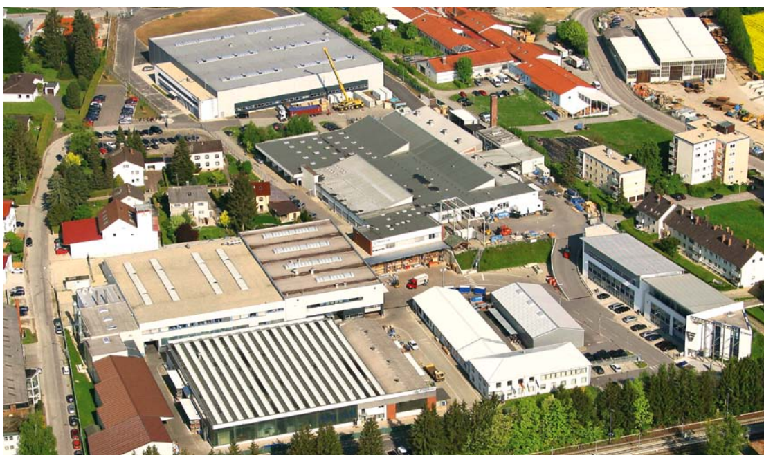
Sede principal en Vilsbiburg cerca de Munich, Alemania
