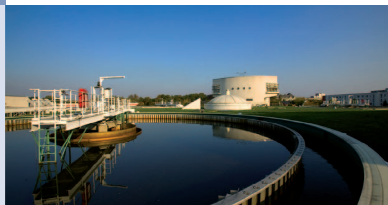
Station de traitement de l'eau à Berlin
